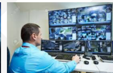
Sistemi di sicurezza integrati
